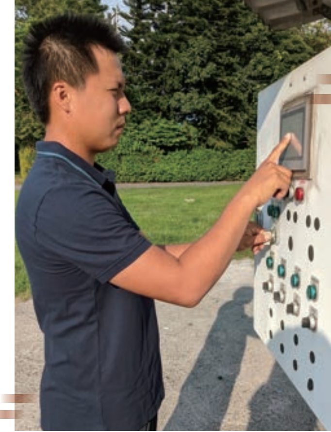
漁場使用的水質監控系統，可現場及遠端操作，相當便利。
